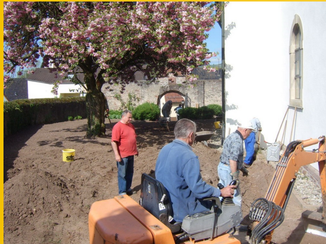
Renovierungsarbeiten an der Kirche in Guttenbach
